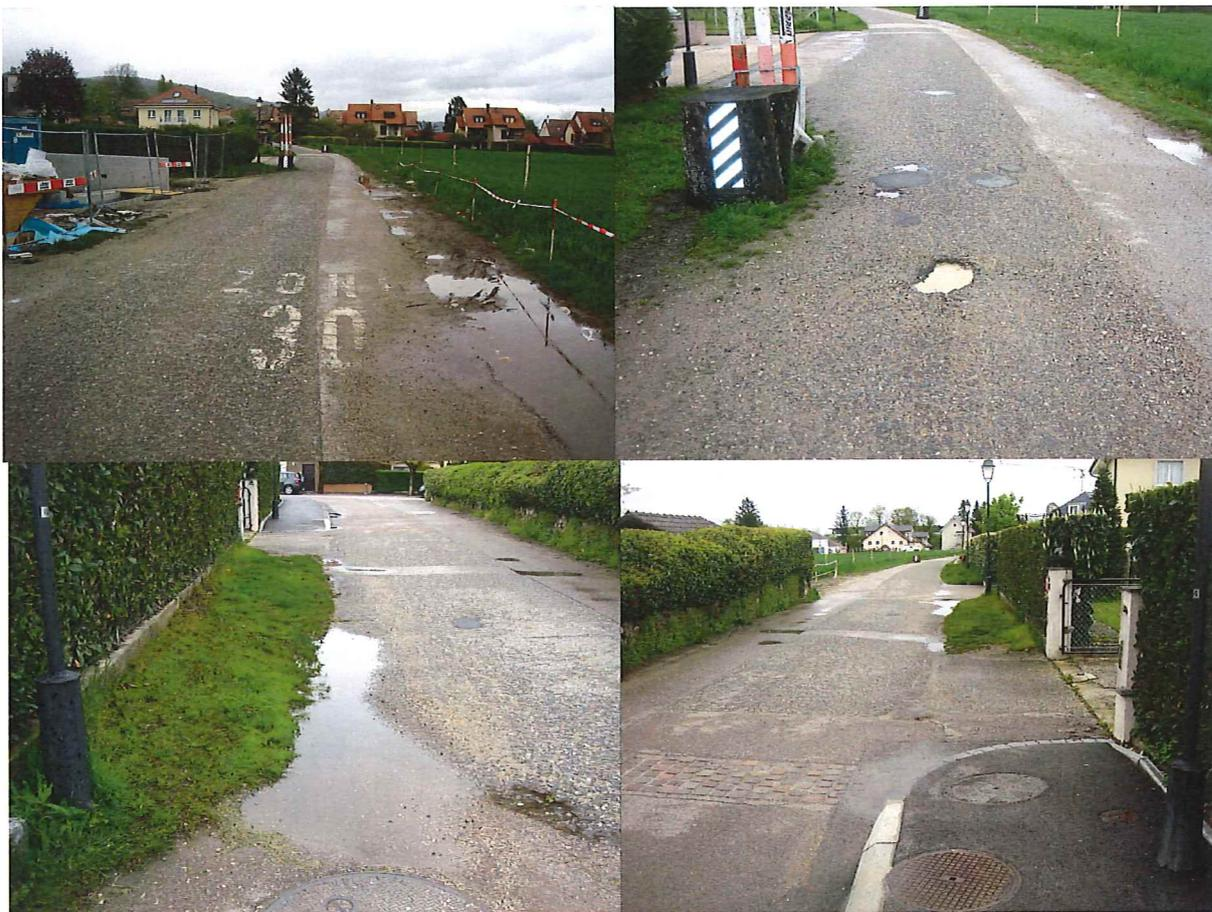
L'écoulement des eaux de ruissellement de la chaussée se fait mal et de nombreuses flaques se créent en temps de pluie. Ce chemin ressemble plus à une piste de chantier qu'à un chemin devant assurer une liaison piétonne attractive entre le quartier de la Duda et les nouveaux arrêts de bus à la route de Gland (giratoire du tram/Aldi).
